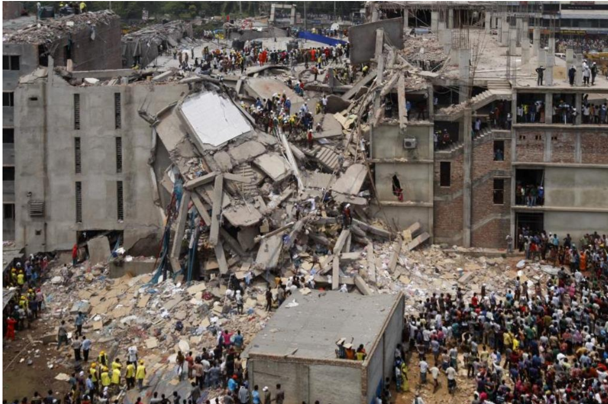
Rana Plaza Einsturz am 24.04.2013
